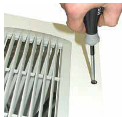
Dévisser la vis de fixation.
