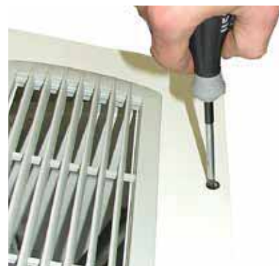
Heben sie die außenverkleidung ein stück an und ziehen sie diese etwas nach vorne.
