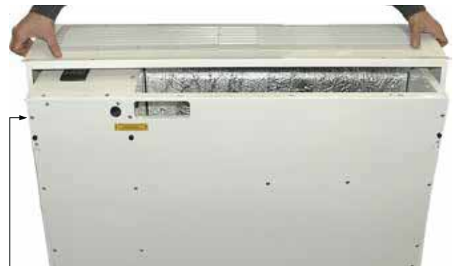
Nach Lösen des Erdungsdrahtes können Sie die Außenverkleidung komplett abnehmen.
